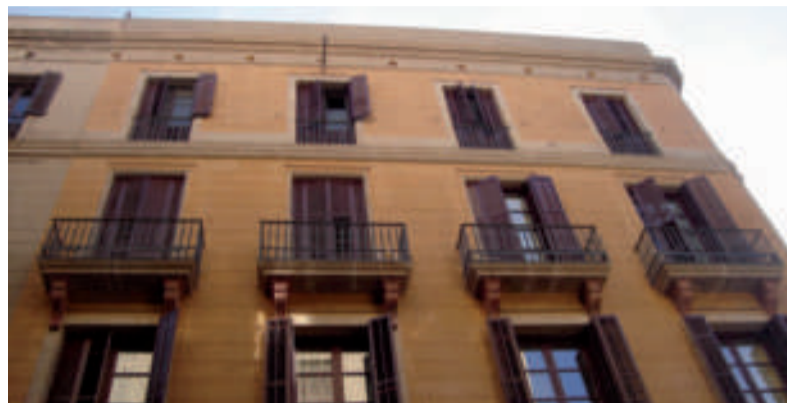
FAÇANA RESTAURADA PER TRAC A LA RAMBLA, 44 (PLAÇA REIAL) DE BARCELONA
